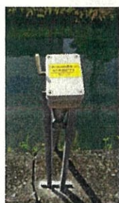
御坊市の用水路に設置されている水位計
