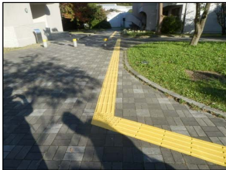
【左：視覚障害者誘導用ブロックの施工写真、右：案内板】
