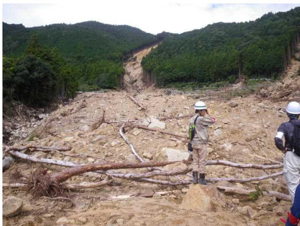
土石流災害現場（那智勝浦町）
